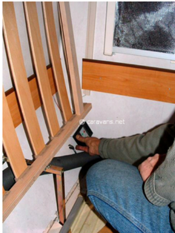
De verbinding tussen zij- en achterwand wordt gecontroleerd
