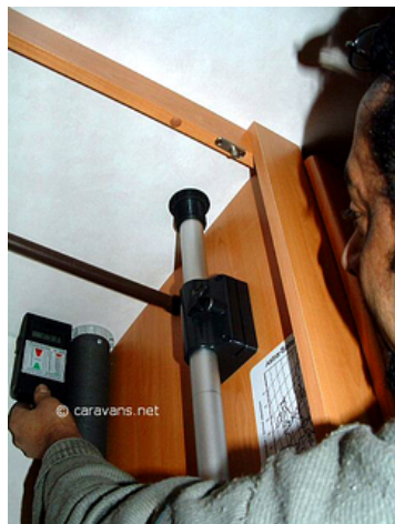
De doorvoer van de schoorsteen is een bekend risicogebied
