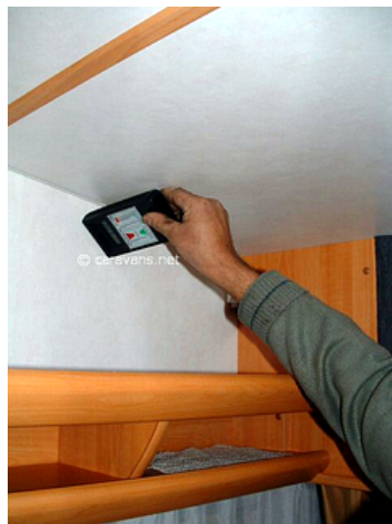
De verbinding tussen dak en wand worden in de hoeken gemeten
